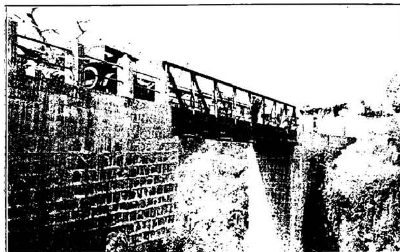
Puente de «La Agronomía». Está montado sobre el Río Ceniza, entre Sonsonate e Izalco. Resistente el peso de un camión de cinco toneladas
