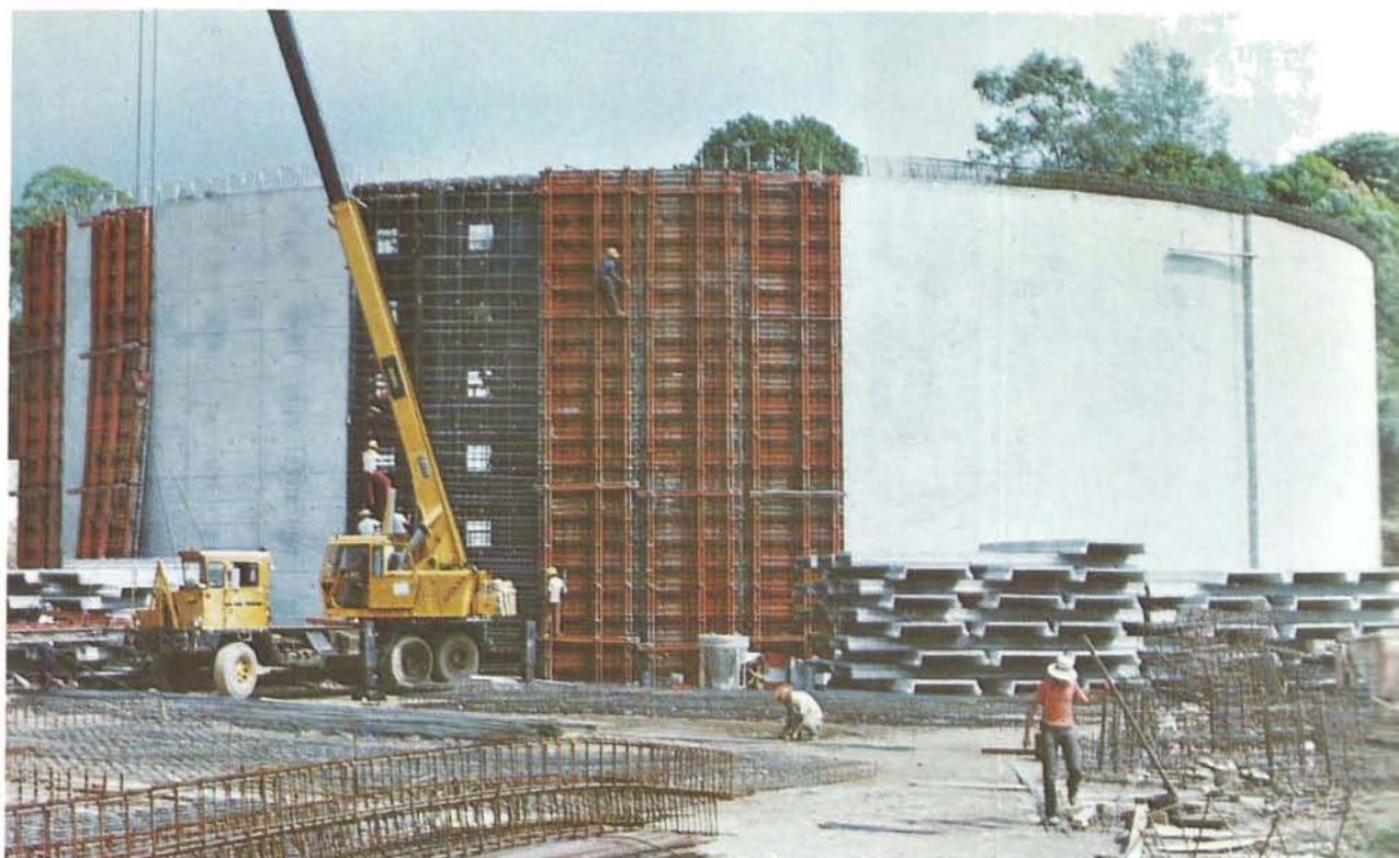
TANQUE EL CARMEN, SAN SALVADOR. CAPACIDAD: 20,000 m3.
