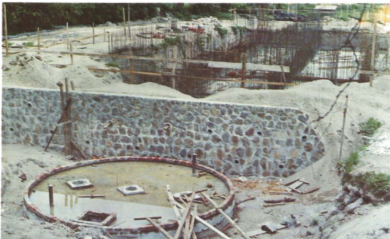
VISTA PARCIAL DE LAS OBRAS DEL PROYECTO RIO CUAYA. PRODUCCION ESTIMADA: 130 Lts./Seg.
