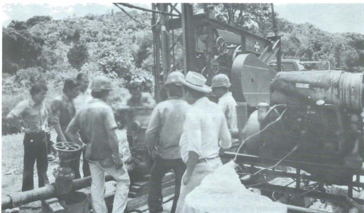
PRUEBAS DE BOMBEO, CHALATENANGO
