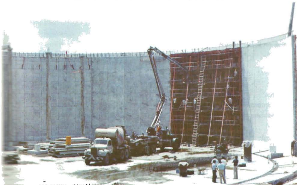
TANQUE "EL CARMEN", SAN SALVADOR. CAPACIDAD: 20,000 m 3 .
