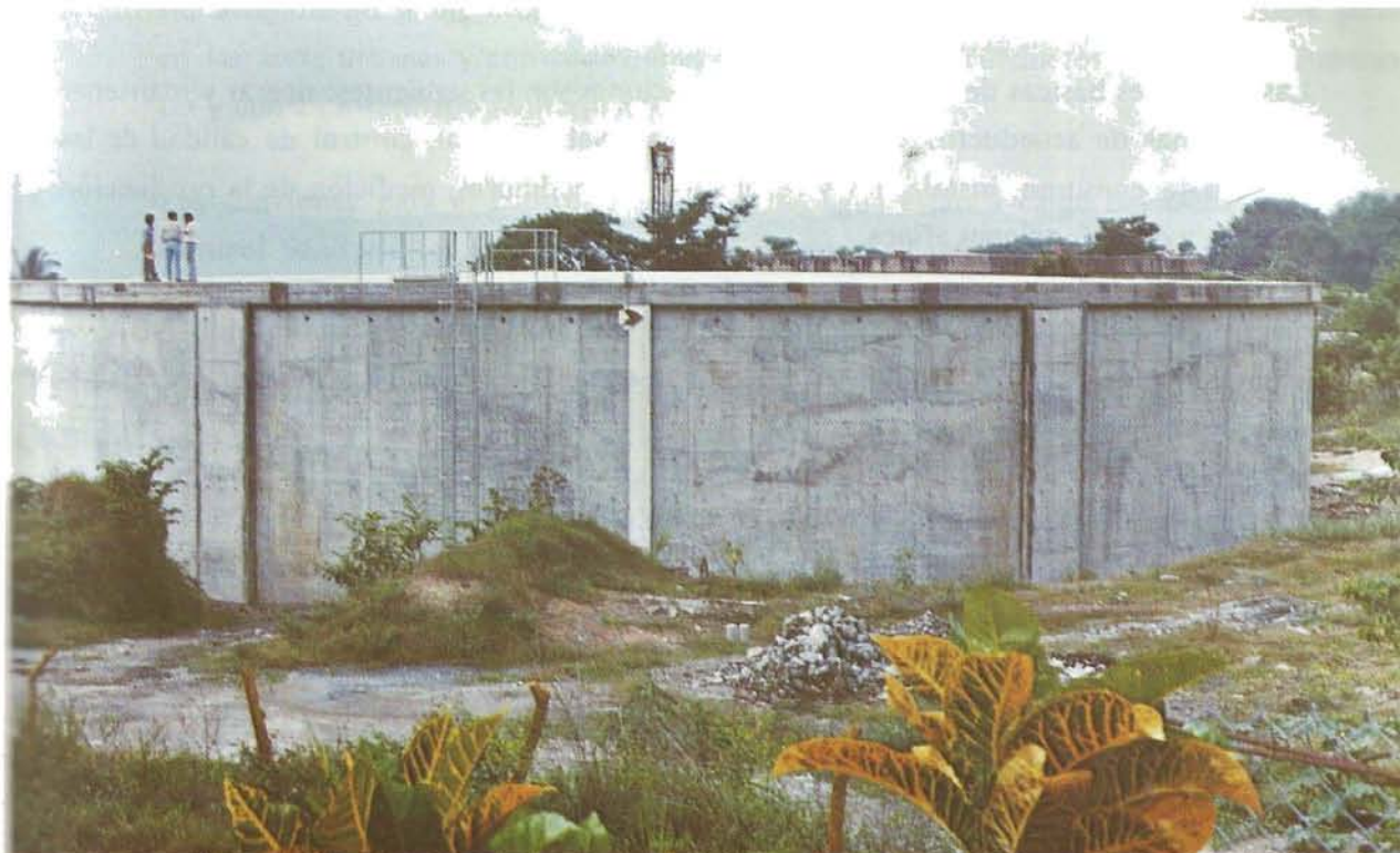
TANQUE MIRALVALLE, SAN SALVADOR. CAPACIDAD: 6,000 m 3 .
