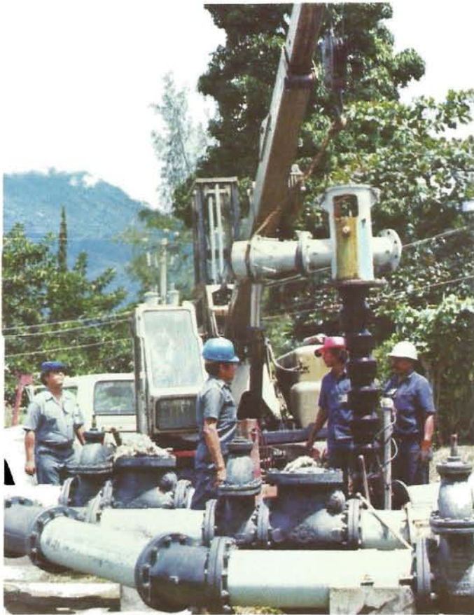
MANTENIMIENTO PLANTA REBOMBEO SCANDIA, SAN SALVADOR
