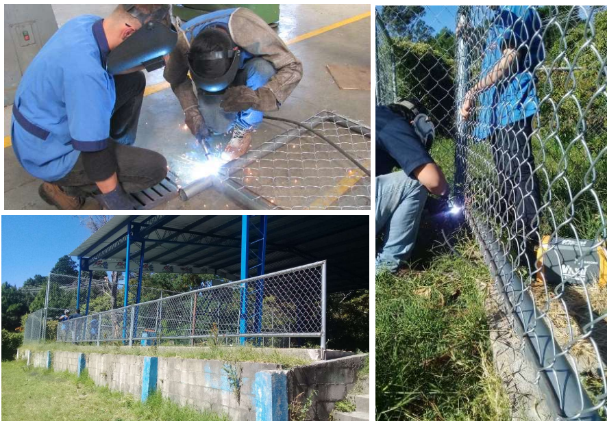
Estudiantes durante la fabricación e instalación de barda de protección de las áreas deportivas en el Complejo Educativo.
