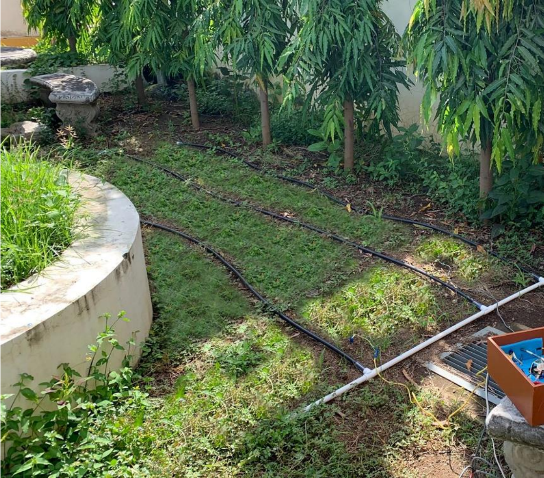
Figura 23. Instalación de tubería parcela San Miguel.
