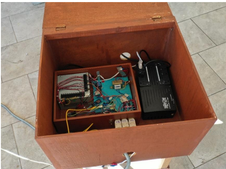
Figura 26. Instalación de unidad de control, parcela San Miguel.
