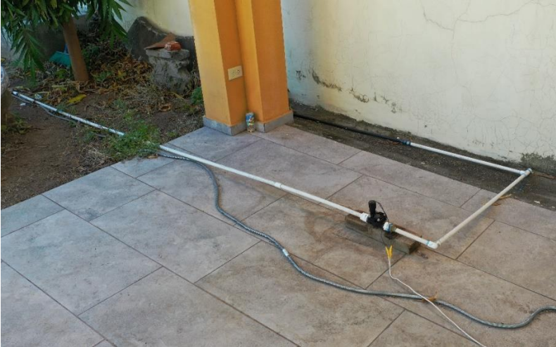
Figura 24. Instalación de electroválvula, parcela San Miguel.
