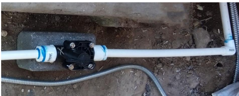
Figura 35. Instalación de electroválvula en parcela de Chalatenango.
