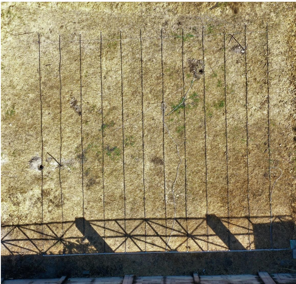
Figura 34. Instalación de tubería en parcela de Chalatenango.
