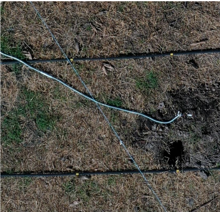
Figura 26. Instalación de sensor en parcela de Chalatenango.
