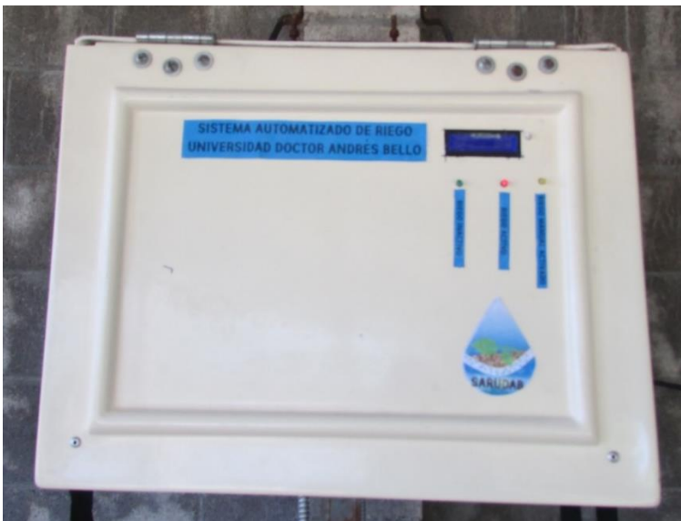
Figura 28. Caja de unidad de control en parcela de Chalatenango.
