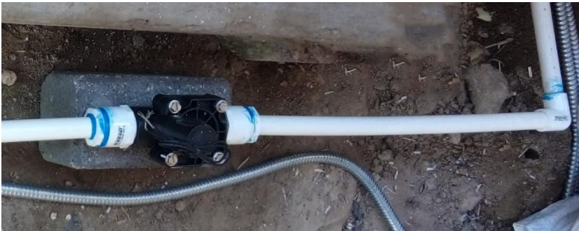
Figura 25. Instalación de electroválvula en parcela de Chalatenango.
