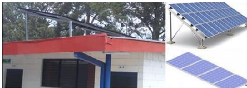
Figura 25. Soportes para paneles solares. 25
