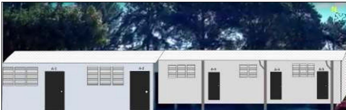
Figura 34. Vista frontal del edificio “A”
