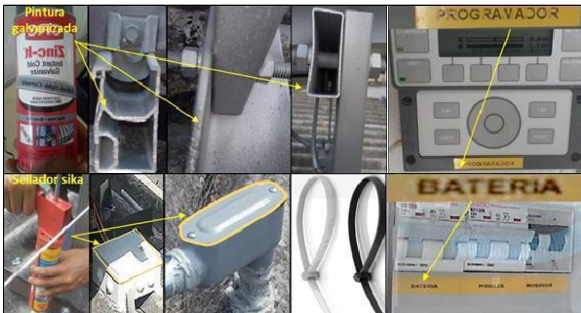
Figura 80. Acciones realizadas para corregir las observaciones de la supervisión.
