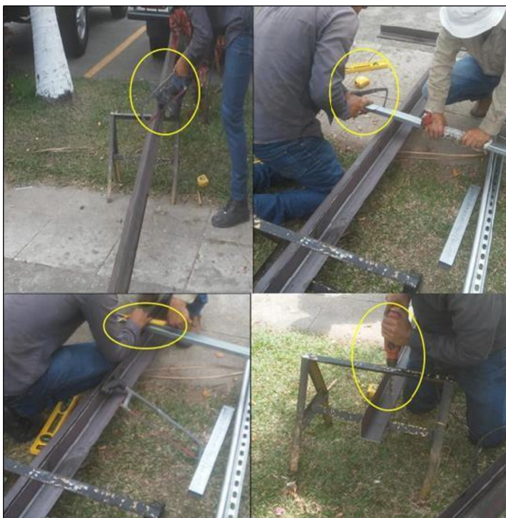
Figura 63. Corte y perforación de las partes de la estructura
