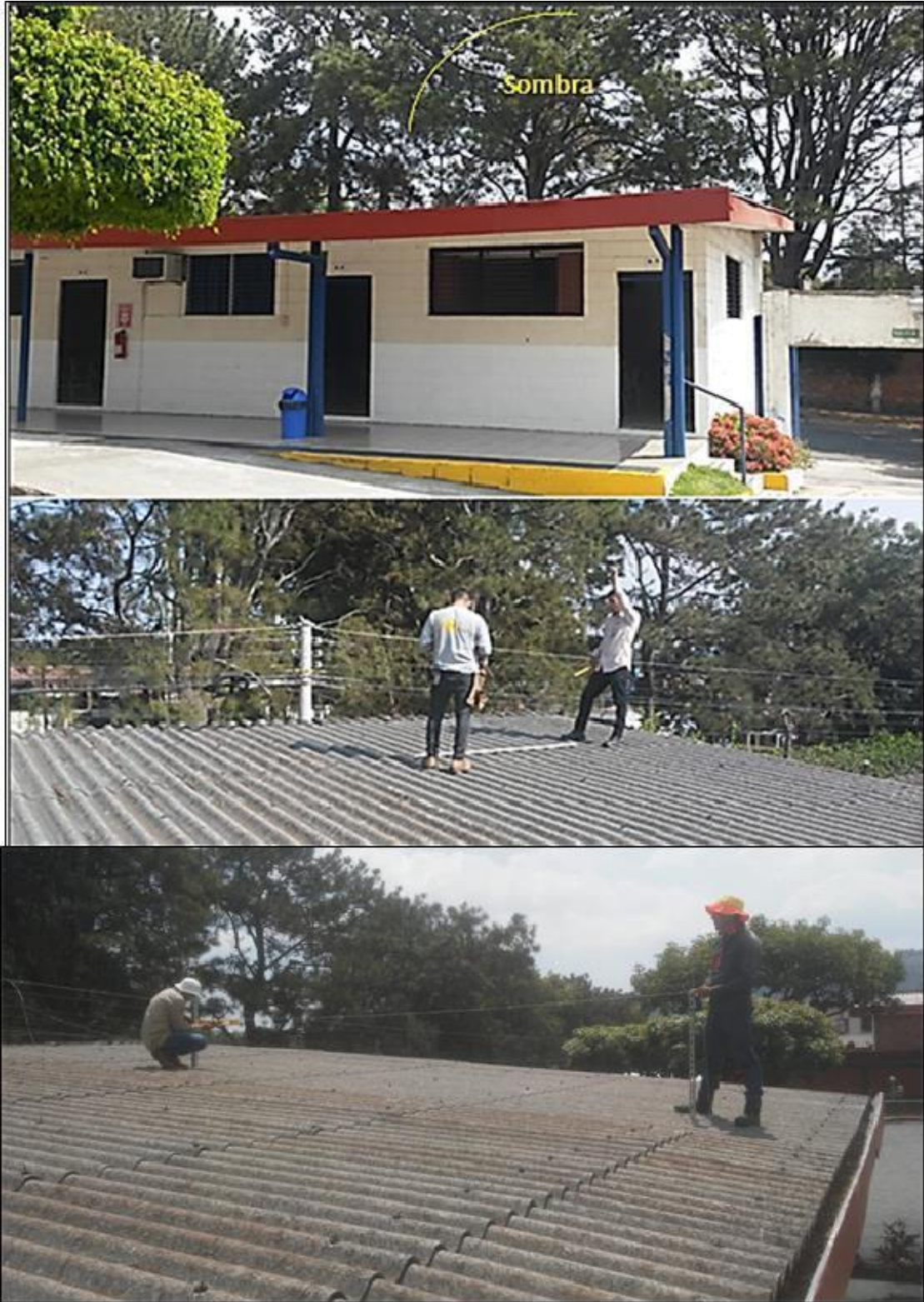
Figura 62. Inspección del techo
