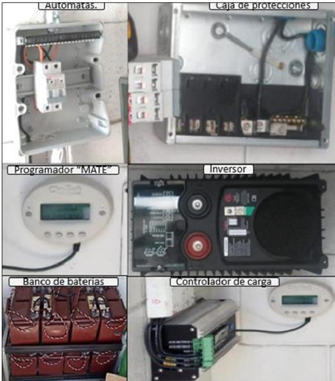
Figura 70. Fijación del equipo de regulación, control y protección a la pared.
