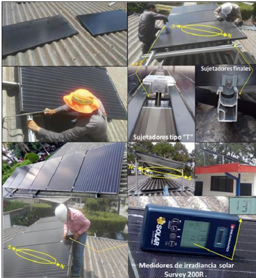
Figura 65. Montaje de los paneles solares sobre el soporte en el techo.
