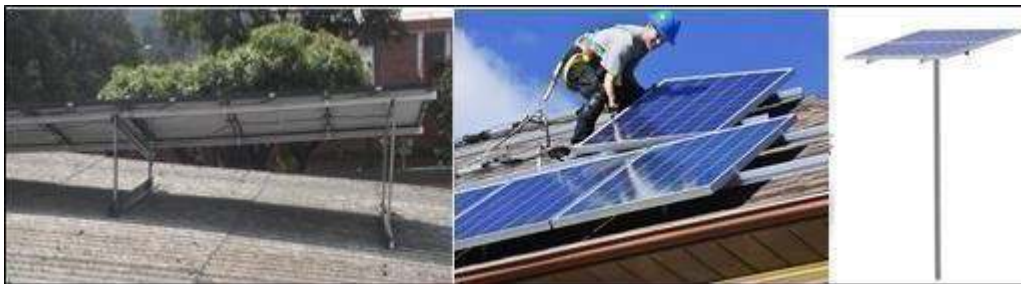
Figura 27. Bases para el montaje de paneles solares. 27
