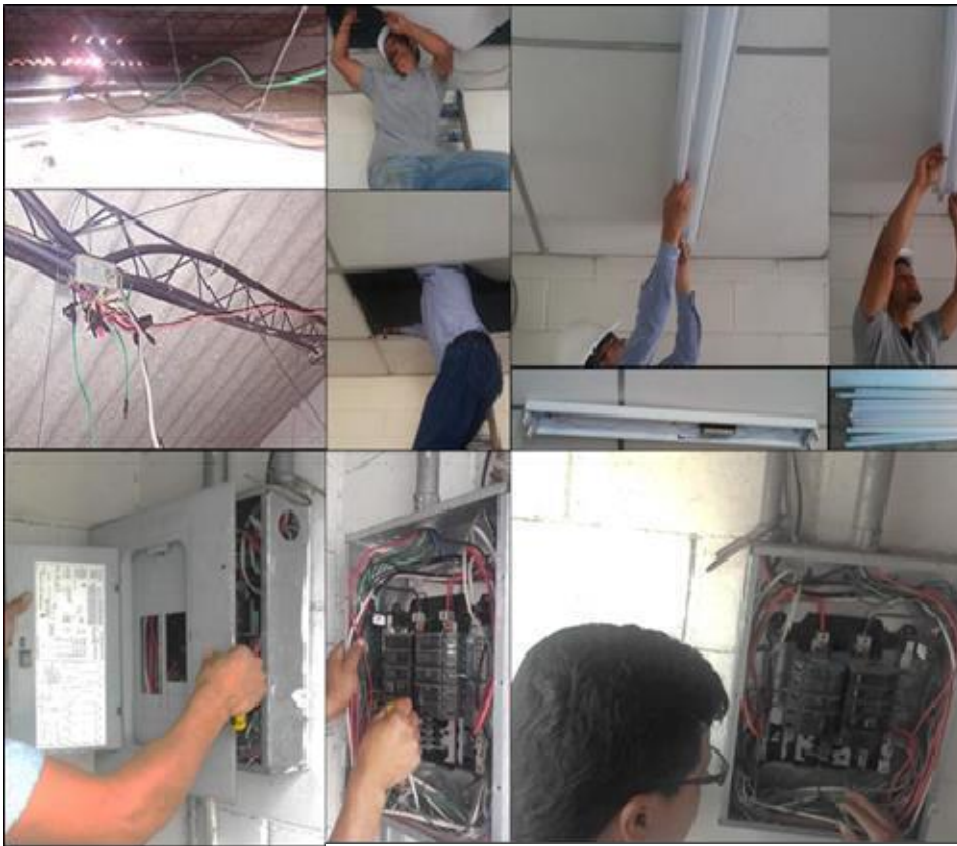
Figura 61. Readecuación de circuitos y cambio de luminarias fluorescentes
