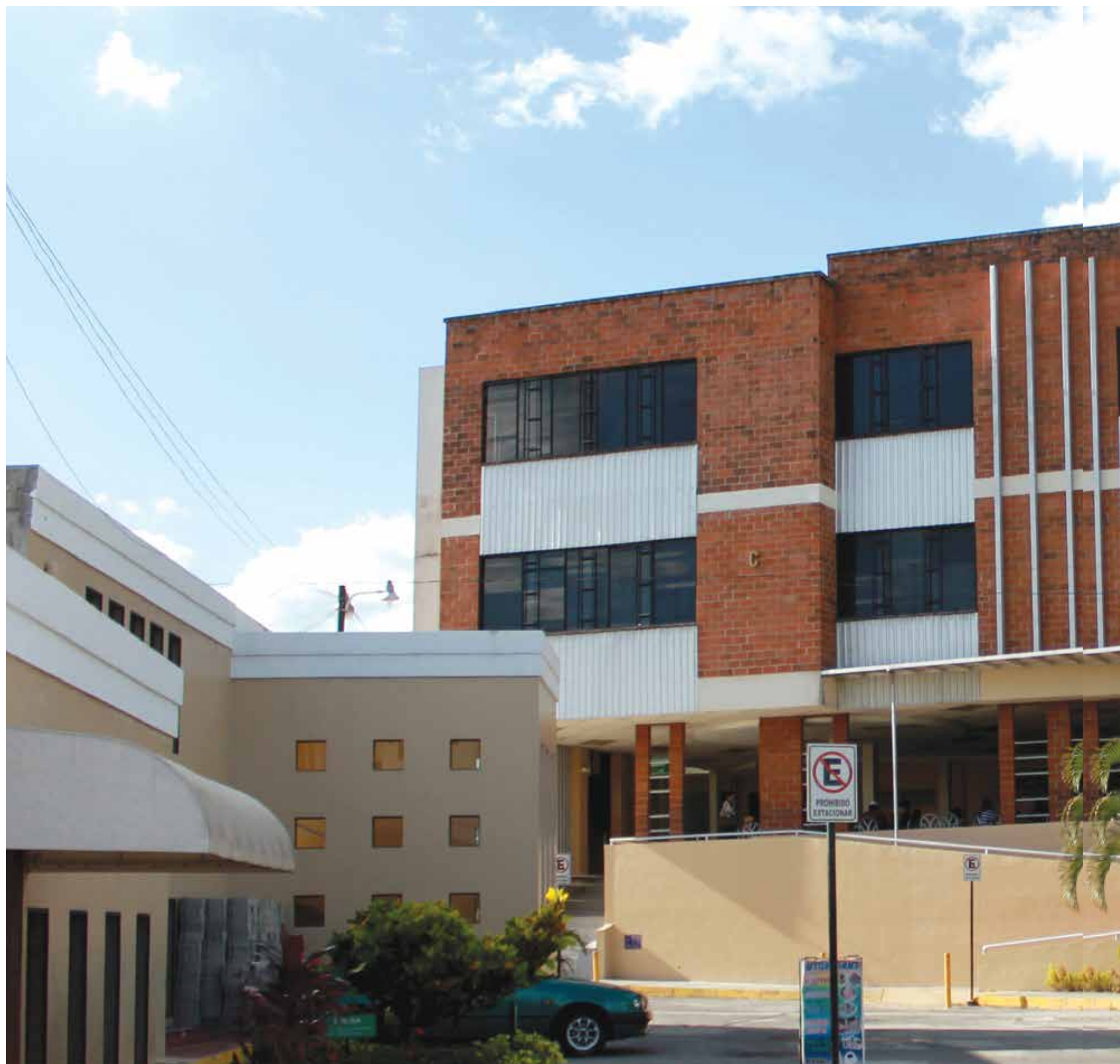
Instalaciones de la Universidad Pedagógica, Módulo "C". Construido en 2013.
