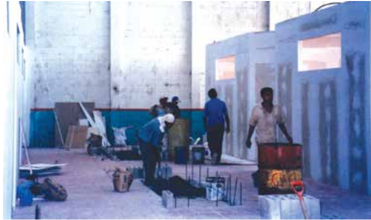
Trabajos de construcción del nuevo campus, año 2002.
