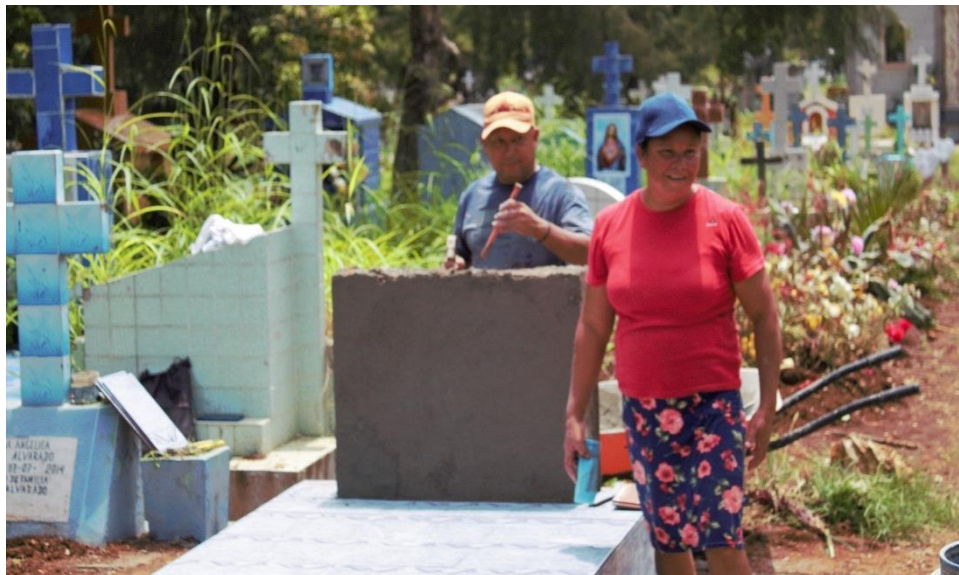
Figura 31. Se observa una de las actividades diarias en el cementerio, la restauración o construcción de tumbas, lapidas o nichos, (2022). Fotografía por: Melissa Mayén.
