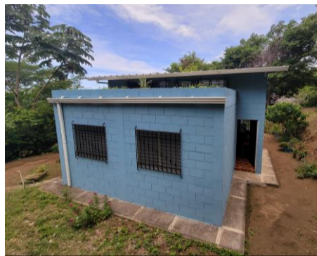
Fachada posterior vivienda bioclimática.
