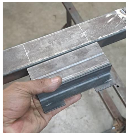
Instalación final de alzas metálicas.
