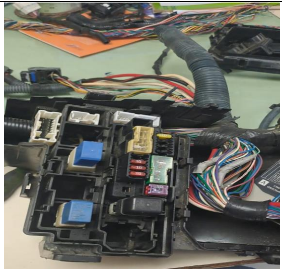
Prueba de circuitos de protección.
