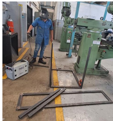
Proceso de unión con soldadura.
