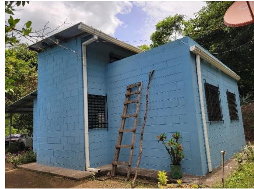
Fachada posterior vivienda bioclimática.
