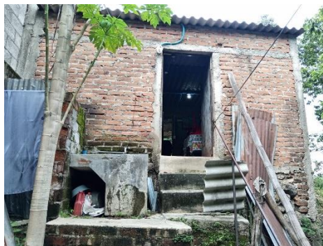
Fachada posterior vivienda ladrillo macizo
