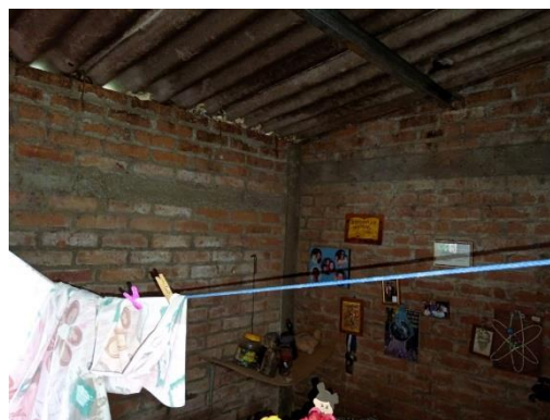
Habitación 2 de vivienda ladrillo macizo
