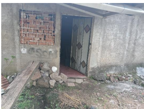
Fachada principal vivienda ladrillo macizo
